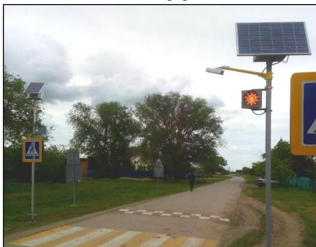
Используемые в светофоре светодиоды являются наиболее долговечными источниками света и обладают низким энергопотреблением, что позволяет использовать солнечные батареи для обеспечения их электропитания. Установка светофора на солнечной батарее не требует устройства траншей, закупки и защиты кабеля, рекультивации траншей, подключения к электросети, оплаты за электроэнергию.
