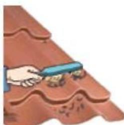
Стружки, образовавшиеся при вкручивании саморезов, необходимо аккуратно смети с поверхности изделия щеткой, иначе они заржавеют и испортят покрытие.
